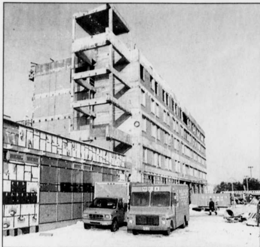
(Image-Média Mauricie; Patrick Beauchamp) Les travaux d'agrandissement du pavillon Sainte-Marie du Centre hospitalier régional de Trois-Rivières ont nécessité des investissements de 14,7 millions de dollars en 2000.
