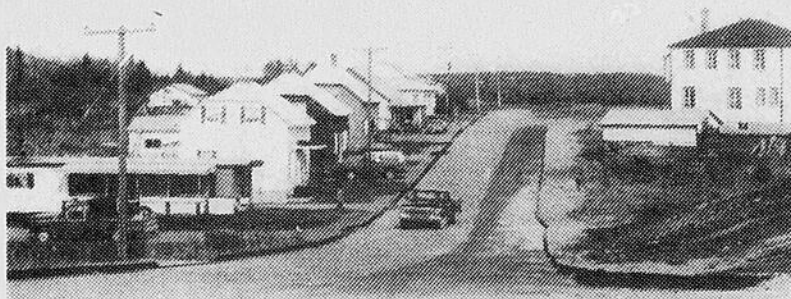
RUES ASPHALTEES — Dans le cadre de la grande métamorphose de Sainte-Hedwidge, on remarque des rues asphaltées et des maisons rénovées. Cette dernière opération s'est fait grâce à un programme de rénovation de logements.
