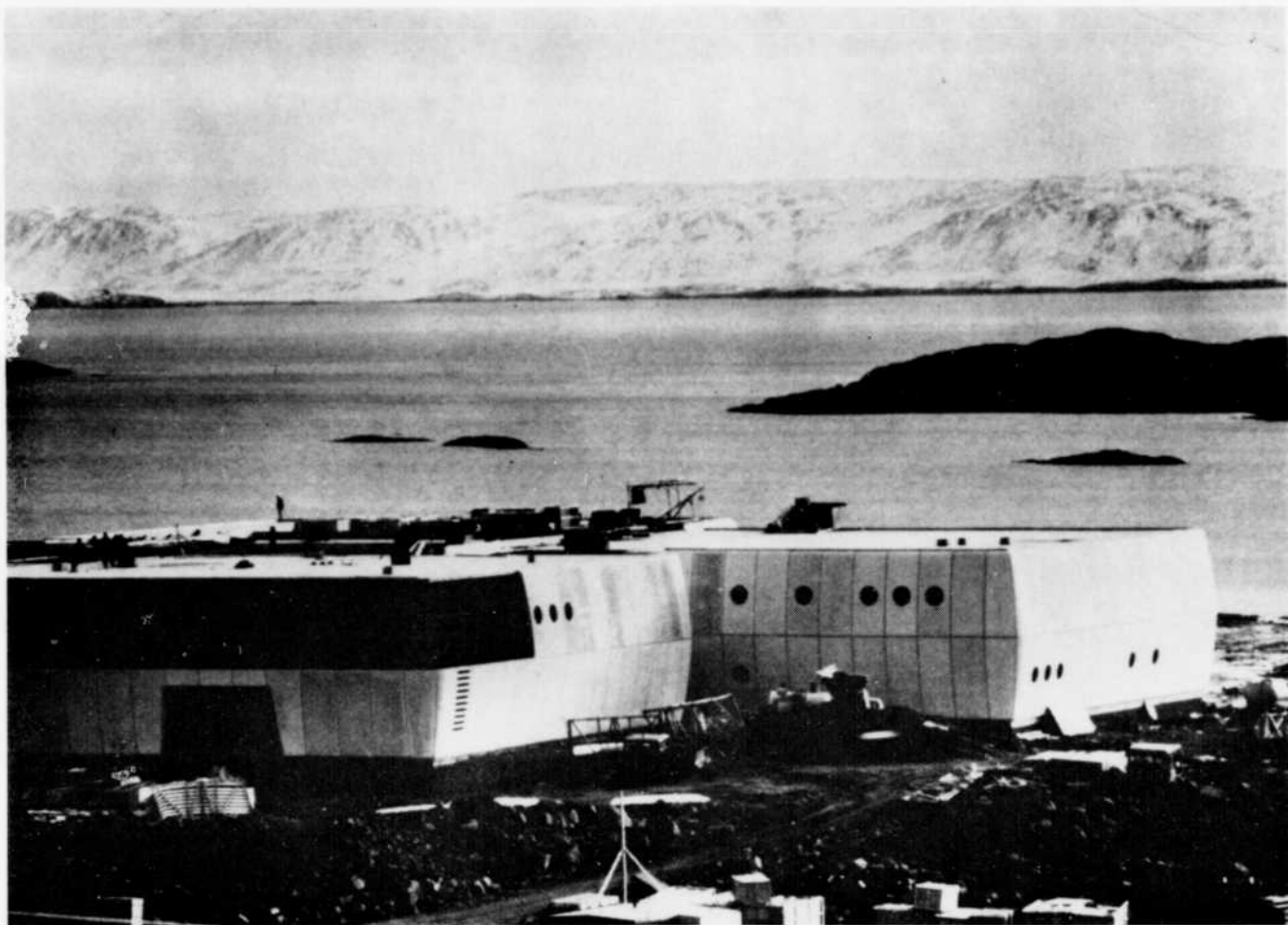
Figure 2 — Les caractères géographiques de l'emplacement, terrain montagneux et sol congelé, sont autant de contraintes architecturales et techniques — ils rendent difficiles et onéreux le transport, la manutention et l'érection des matériaux de base.
