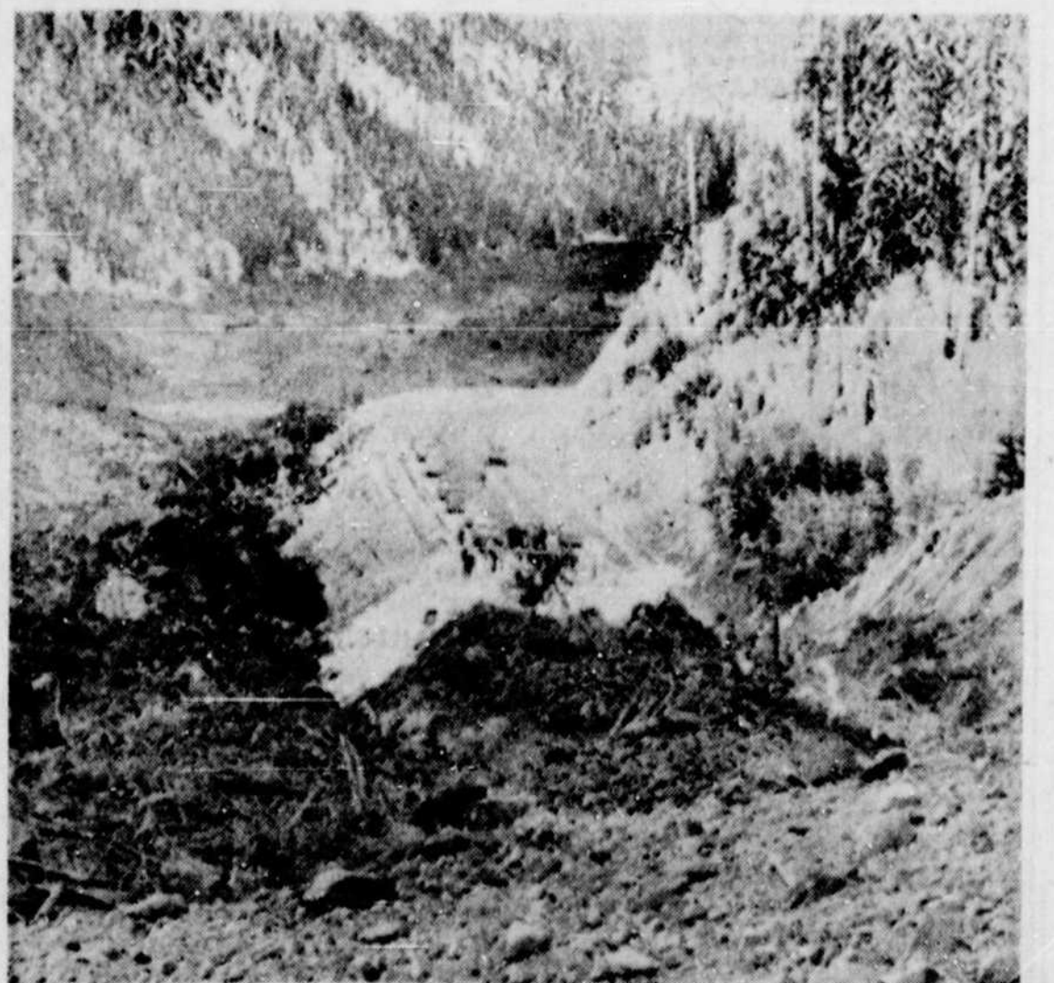
● HOPE, C.-B. — Le versant d'une montagne s'est effaissé en fin de semaine sur une route entraînant la mort de quatre personnes et détruisant deux camions et une automobile. Deux volontaires, fouillant les débris à la hâte, ont trouvé les corps de deux hommes dans ce qui restait des camions, hier. (Téléphoto UPI)
