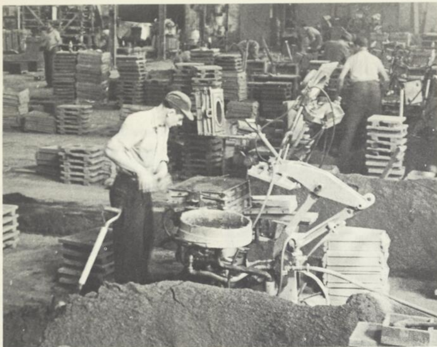
▲ Dans la salle des moulages, on prépare les moules avec du sable lui-même placé dans une boîte à noyaux fermée de tous côtés avec seulement quelques trous de coulée où le métal est versé.
