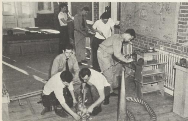
Un groupe de cadets occupés sur une épissure à oeillet d'un cordage de dix pouces de circonférence et, à l'arrière plan, d'autres pratiquent l'épissure à oeillet sur câble d'acier.
