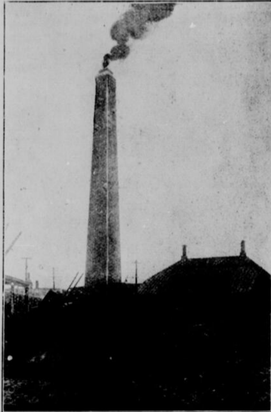
Les bâtiments et la très haute cheminée des incinérateurs-destructeurs.
