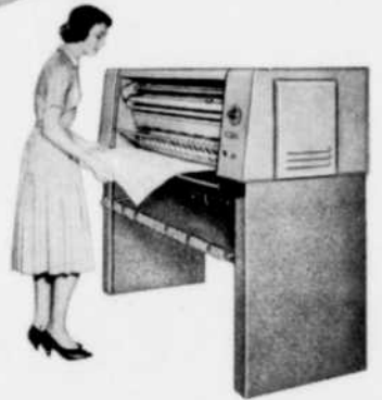
Modèle Copyflex 320 — Machine à tirage conçue pour reproduire des tracés mesurant jusqu'à 42 pouces de largeur. Économique, peu encombrante.
