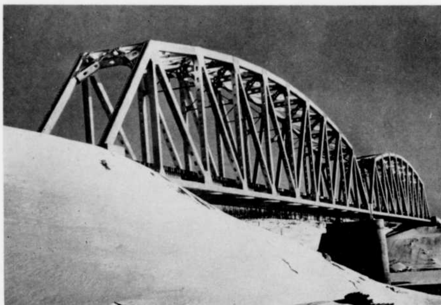
L'un des 17 ponts du chemin de fer.
