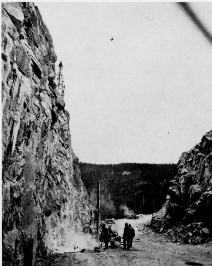
Coupe dans le roc solide sur le tracé du chemin de fer.
