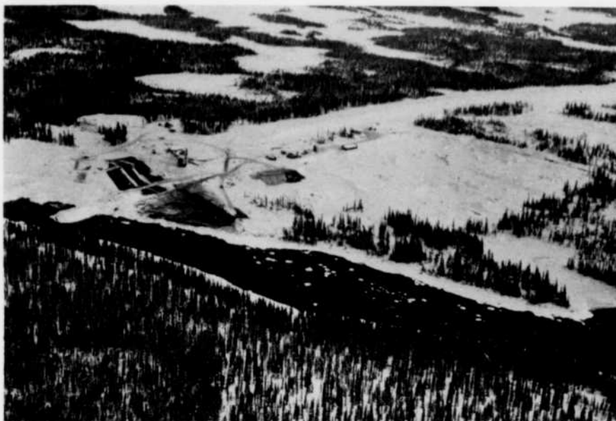
Un des barrages en construction sur la rivière Hart-Jaune qui fournira les 60,000 h.p. nécessaires aux opérations minières et au concentrateur du lac Jeannine.
