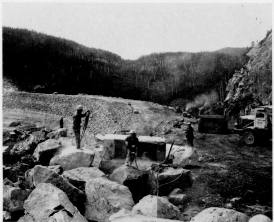
Remblai sur le tracé du chemin de fer qui permettra le transport chaque jour des trains de 125 wagons d'une capacité de 100 tonnes chacun.
