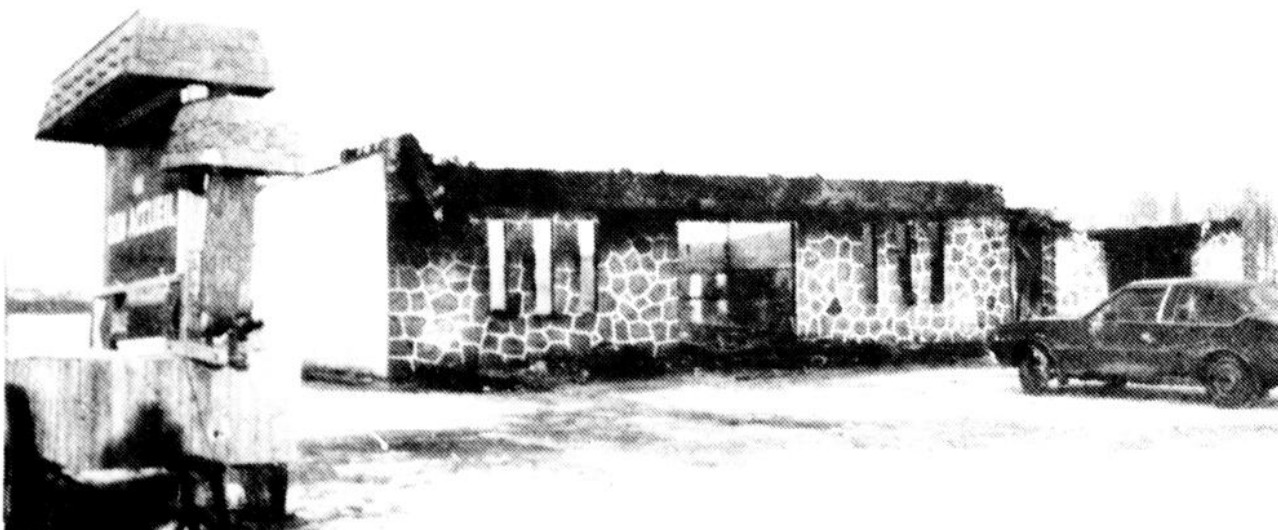
Le restaurant «Au Bon Accueil» de Pointe-Lebel a été complètement détruit par le feu mardi, le 18 décembre dernier.
