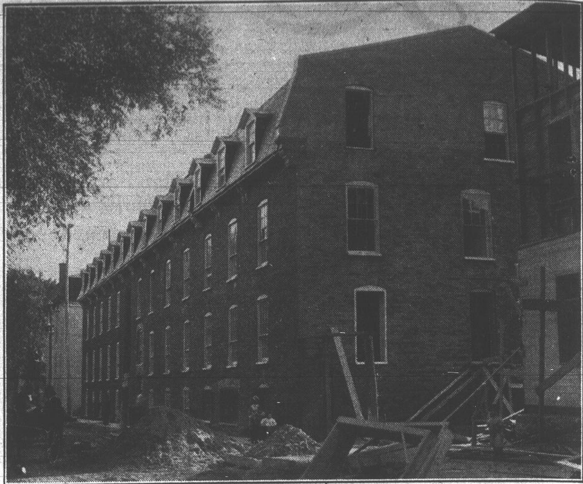
Les travaux de construction qui ont transformé l'ancienne poterie MacDonald pour en faire le collège de Saint-Jean. C'est en l'année 1911 que ses travaux furent effectués.
