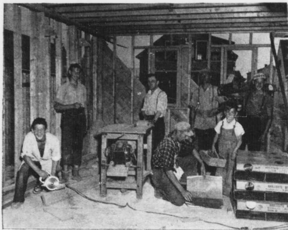
La famille de M. Albert-A. Bouchard, photographiée avant de commencer une soirée de travail à la construction de leur nouvelle résidence, avec les charpentiers MM. Louis et Jean Plourde du Lac-Bouchette. De gauche à droite, Florent, Yvan, M. Albert-A. Bouchard, le père, M. Louis Plourde, M. Jean Plourde, André et Didace.
