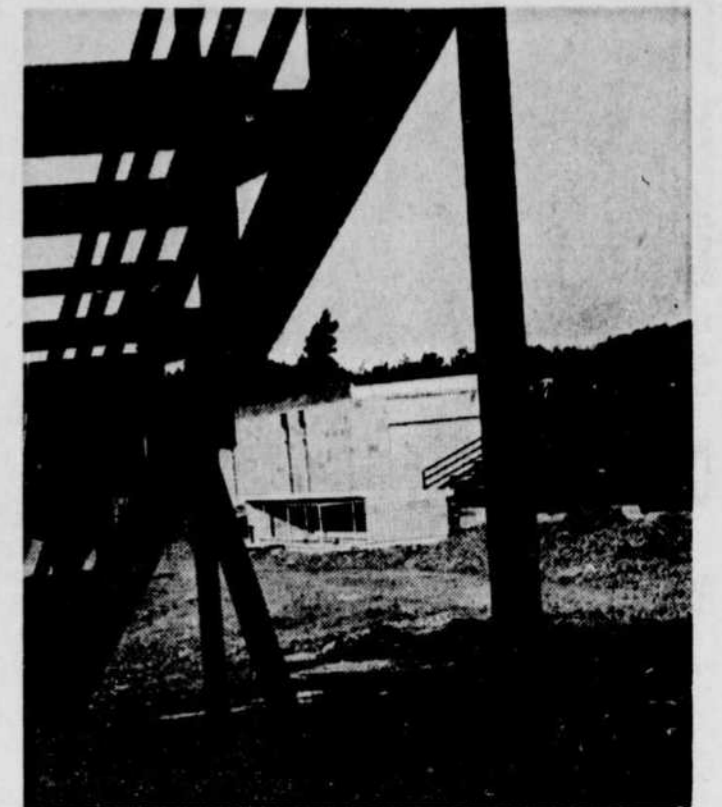
Les travaux du parc-école de Lévis vont bon train. Le premier terrain de jeux doit être prêt en août. Les jeunes de la Rive-Sud attendent avec impatience le début des activités sur ce terrain doté d'un équipement des plus modernes. (Photo l'Action-Québec, Claude Parent)
