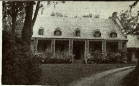
"Le Manoir", à Belle-Plage et l'un des pavillons attenants.
