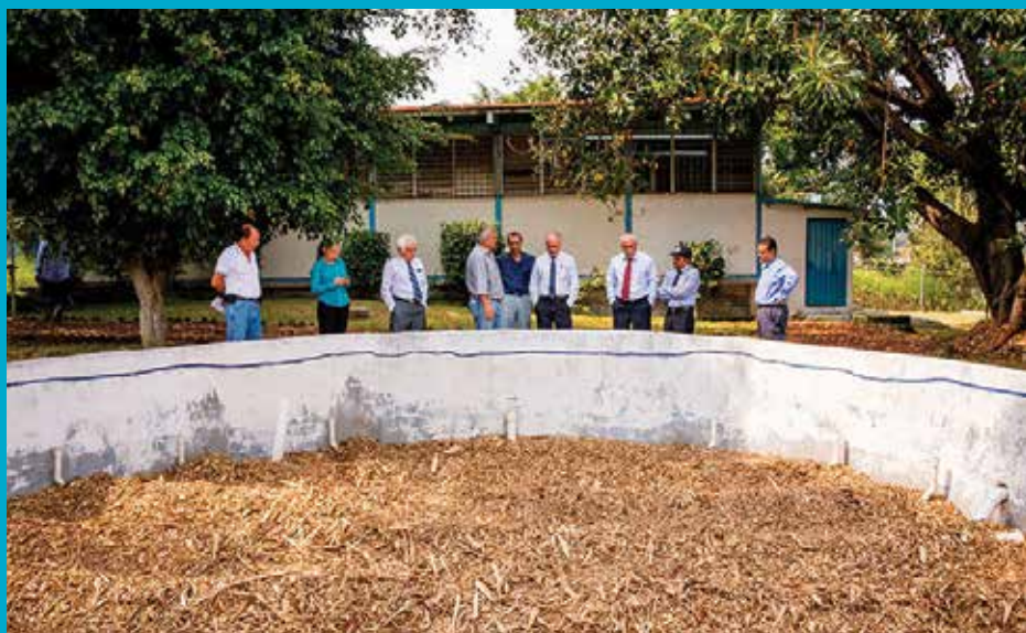
Système de biofiltration BIOTROP MD installé à l'École secondaire Gonzales-Bocanegra, située dans la ville de Jiutepec, au Mexique.
