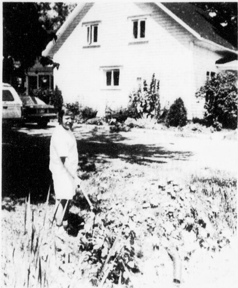
CIEL OUVERT - Maurice Smith, domicilié au 2164, du chemin de la Réserve à Chicoutimi, indique ici la profondeur d'un des fosses du secteur dans lequel des conduites d'égout se déversent. (Photo Rocket Lavoie)
