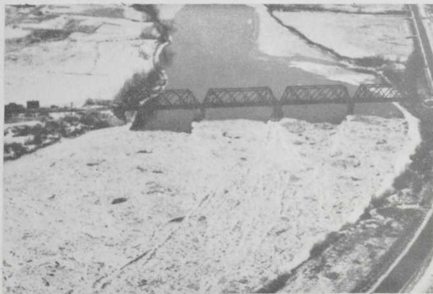
Pont de chemin de fer - Vue en détail.
