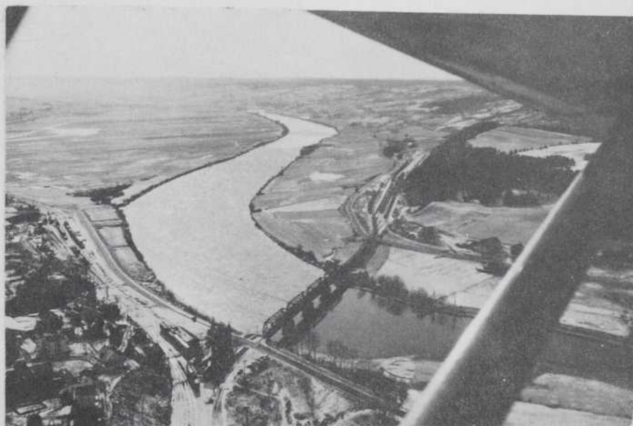
Pont de chemin de fer - Vue générale.
