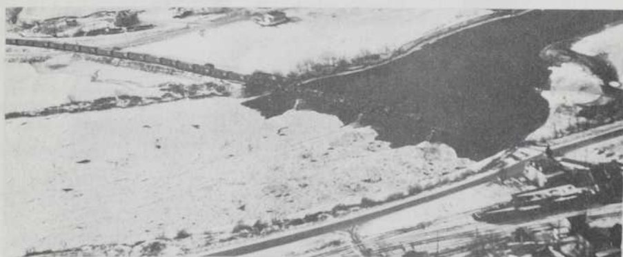
Amorce du champ de glaces par l'arrêt des plaques à une singularité: ici il s'agit d'un rétrécissement de section causé par les piles du pont.
