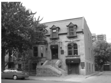
3425-3427, rue Saint-Hubert Maison John-Millen
