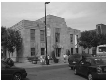
305-309, avenue du Mont-Royal Est Édifice Mont-Royal
