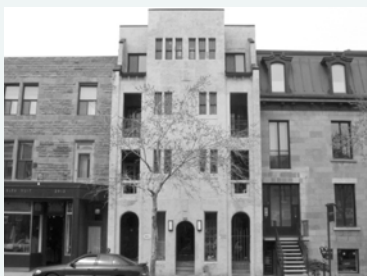
3903, rue Saint-Denis Appartements Laurette
