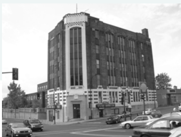
6201, avenue du Parc Édifice Bovril
