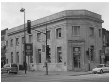
5801-5811, avenue du Parc Ancienne Banque Royale
