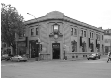
4184-4190, rue Saint-Denis Ancienne Banque d'Épargne
