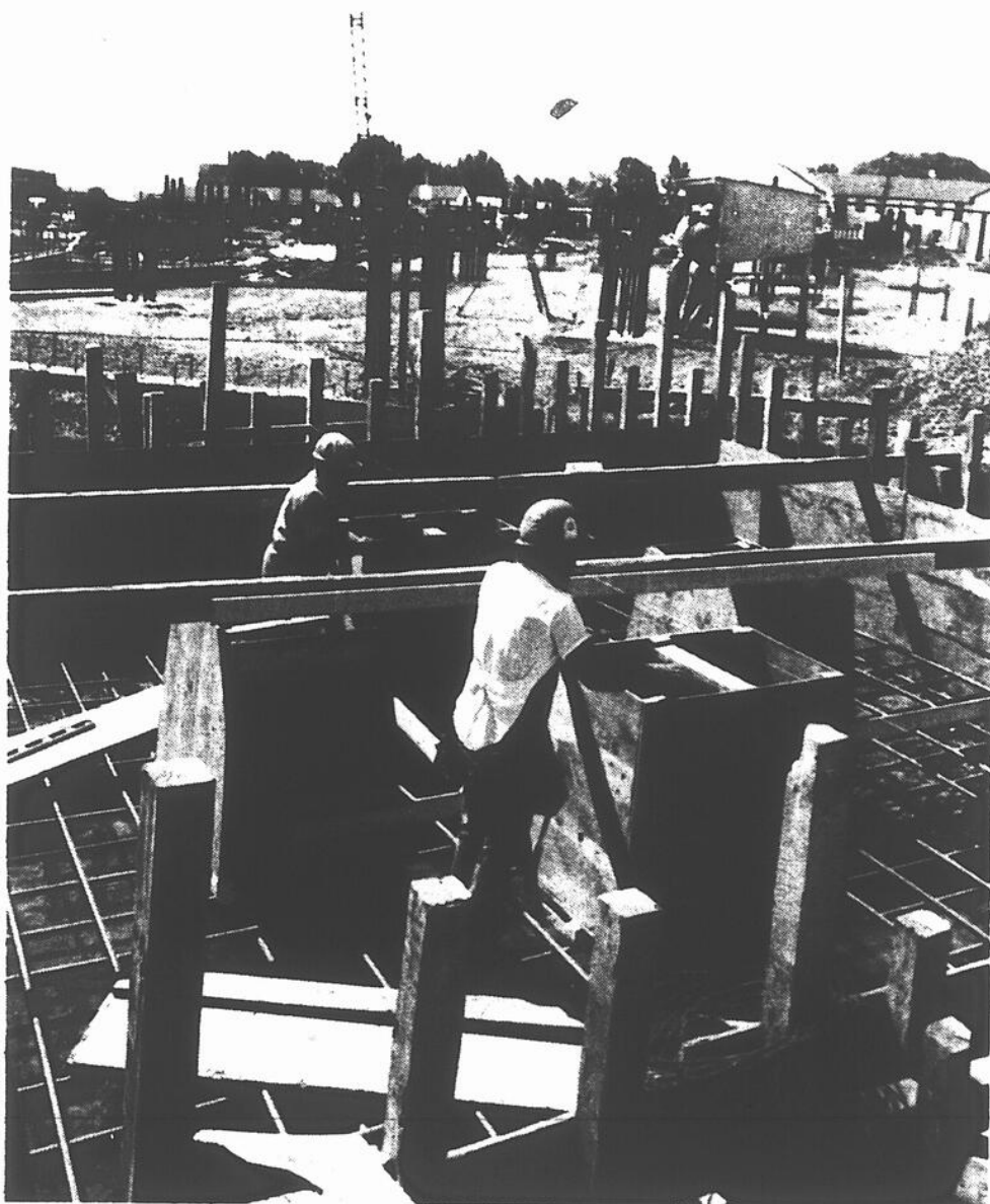
Une cage d'ascenseur en construction.
