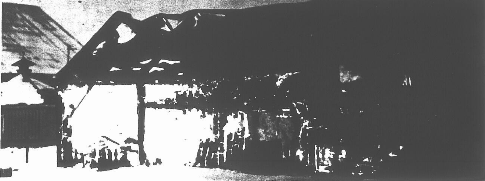
Les bâtiments et installations de ferme recèlent parfois des dangers insoupçonnés.
