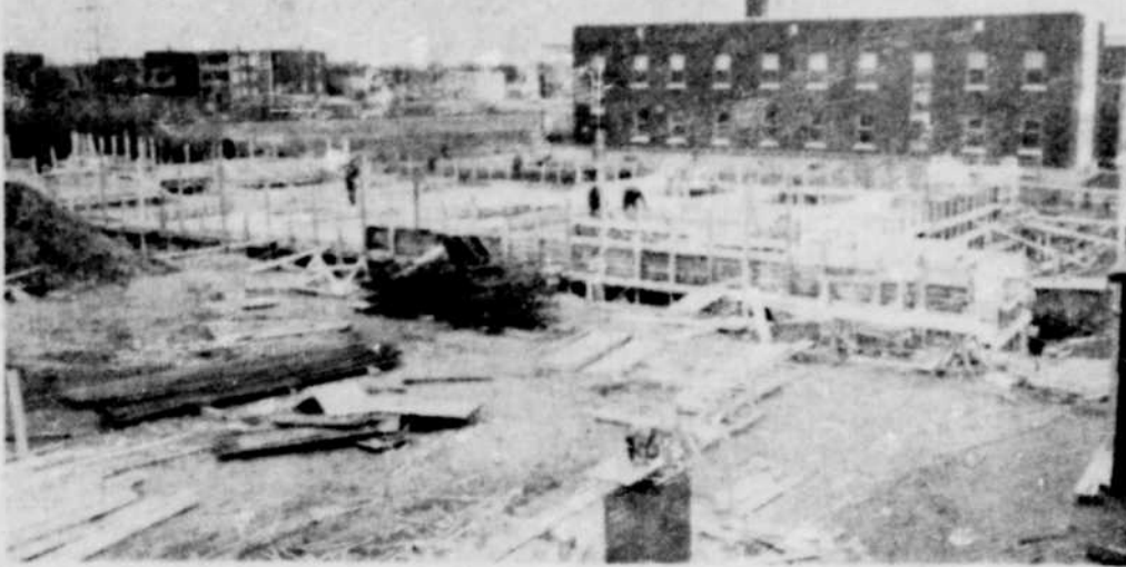
LES TRAVAUX VONT BON TRAIN à l'école Ste-Ursule. On a commencé à couler les fondations. Actuellement les formes sont en place et l'armature du béton est disposée, comme on peut le constater. Les autorités de la compagnie Rapid Construction considèrent être en avance dans les travaux.
