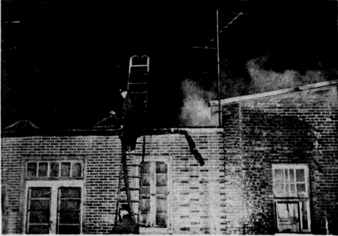
LES SAPEURS HISSENT UN NOUVEAU BOYAU sur la toiture du patronage Saint-Charles. Cette partie arrière de la toiture était par la suite défoncée par les pompiers qui combattaient le foyer d'incendie.
