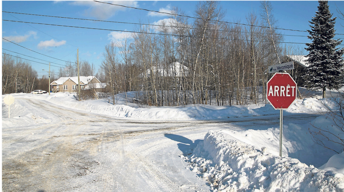
Des rues de Saint-Denis-de-Brompton sont si endommagées que les services d'urgences ont de la difficulté à les emprunter. — PHOTO ARCHIVES LA TRIBUNE, RENÉ MARQUIS
