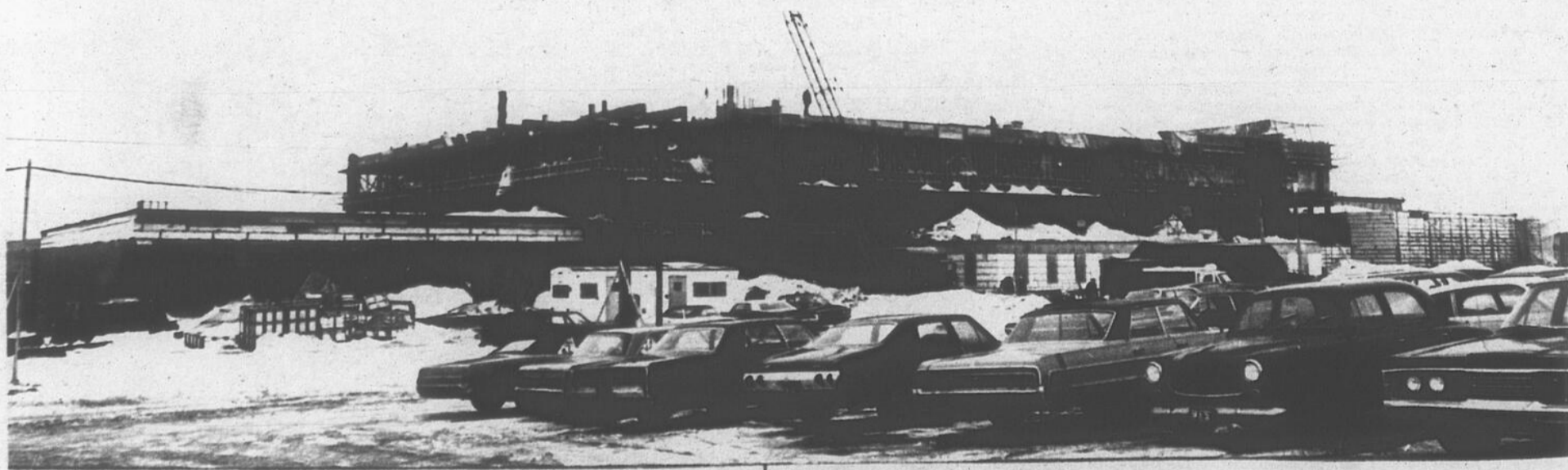
Le chantier de construction de la polyvalente à Lac-Mégantic; elle ouvrira ses portes le 8 avril 1973.
