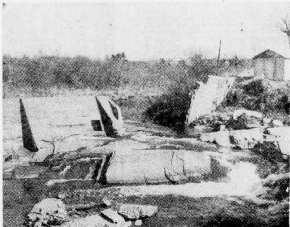
L'ancien barrage, qui sera peut-être rebâti sous peu. Il offrirait de nombreux avantages tels que le contrôle du volume de l'eau et une meilleure protection contre l'incendie. Il ajouterait aussi à la beauté de la ville.
