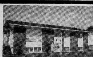
353 Terrasse Bon-Air, Pointe-au-Père. Luxueuse résidence, sous-sol fini.
