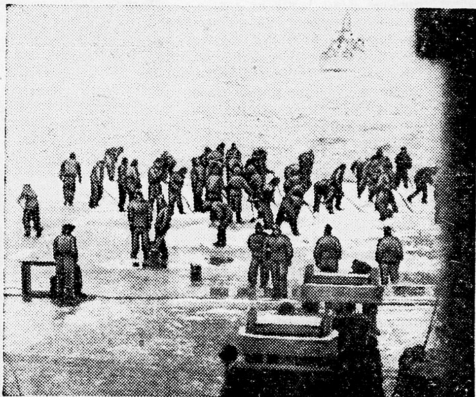
Les hommes du porte-avions "Eagle" portant des vêtements spéciaux contre le froid déblaient le pont de vol de leur navire au moyen de pelles et de jets de vapeur.
