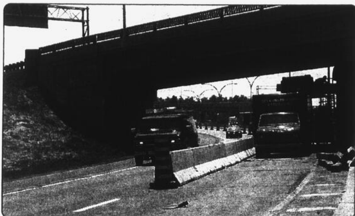
La réparation des piles des ponts d'étagement du viaduc de la route 104 a pour conséquence de perturber la circulation sur l'autoroute 35
