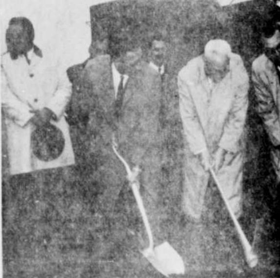
LE NOUVEL HOTEL DE VILLE D'ASBESTOS. — La levée de la première pelletée de terre a eu lieu lundi soir sur l'emplacement du futur hôtel de ville d'Asbestos. De gauche à droite, MM. Jos Eby, gérant de la mine Jeffrey, J.-M. Beauchesne, maire d'Asbestos et Armand Larrivé, président du Syndicat, exécutent ce travail préliminaire sous les yeux intéressés de plusieurs invités. (Photo La Tribune, par Jacques Drapeau)
