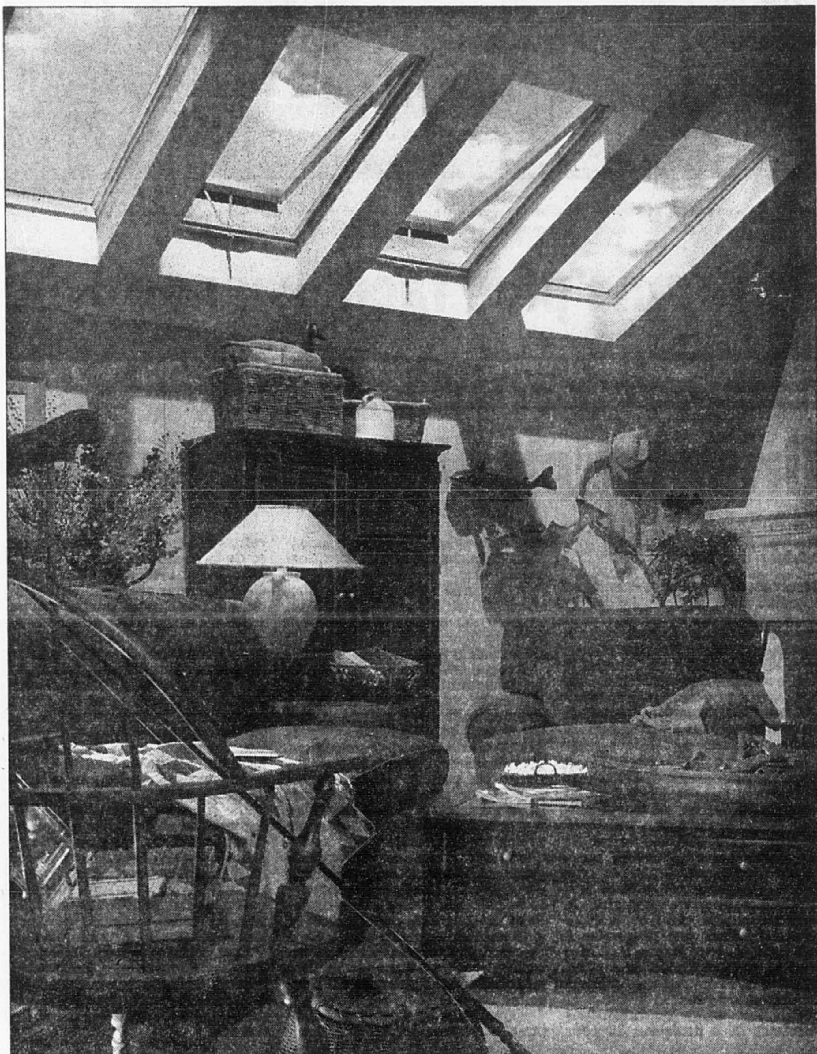
Bien que hors de portée, le puits de lumière peut s'ouvrir ou se fermer à l'aide d'une tige de réglage ou d'une commande électrique.
