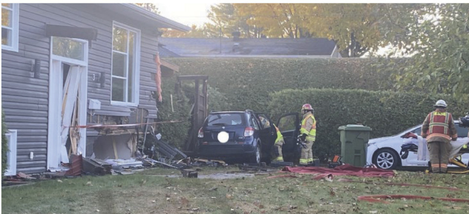
Des blessures mineures pour le conducteur, mais des dommages importants à la résidence. (Photo www.lanouvelle.net)
