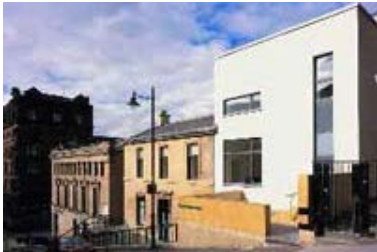
Atelier-résidence à Glasgow
