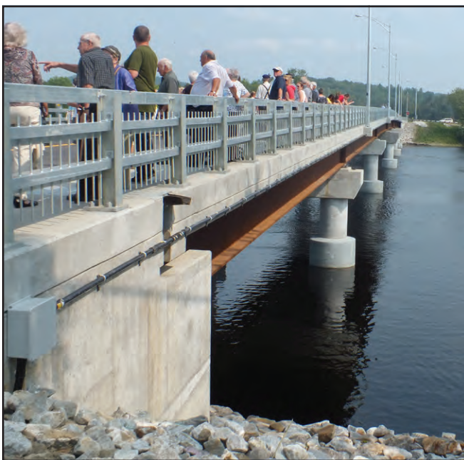
▲ Il s'agit d'un pont en béton armé sur piles, qui n'a plus de limite de poids et de charge. Parmi les ajouts : une voie de circulation additionnelle, un trottoir, de l'éclairage.
