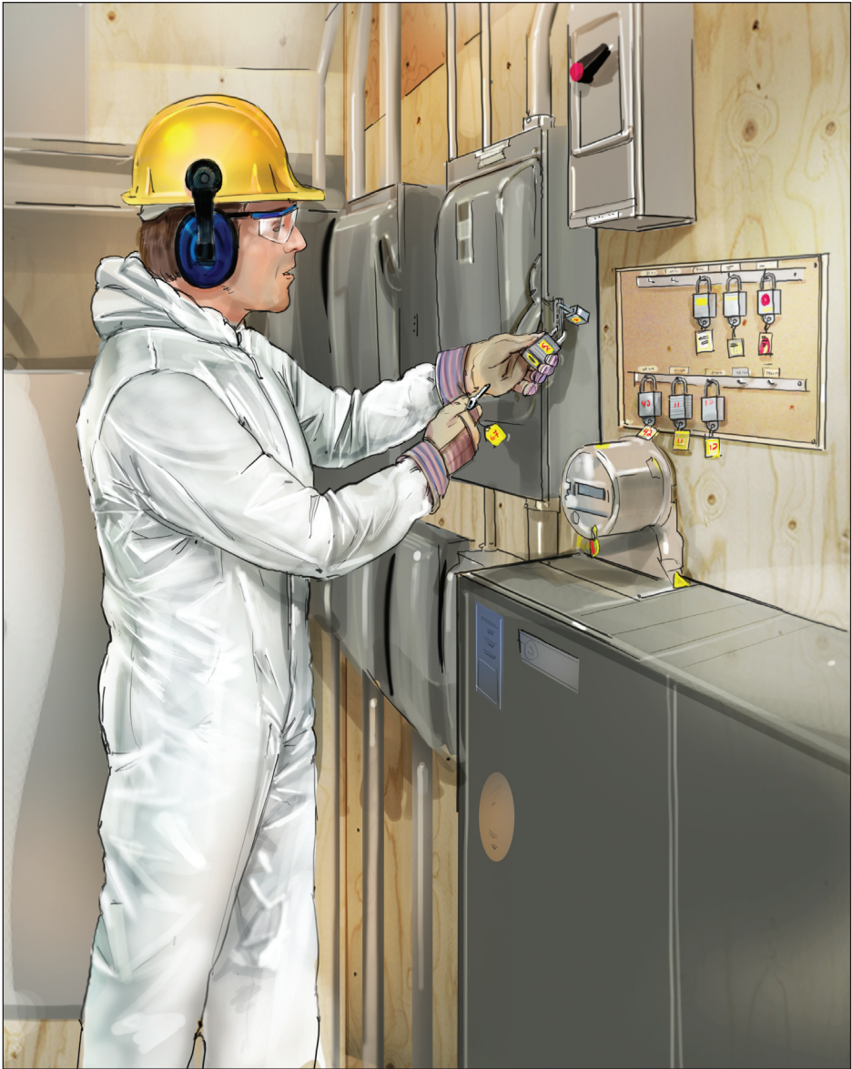
Figure 2 : Cadenassage des sources électriques
