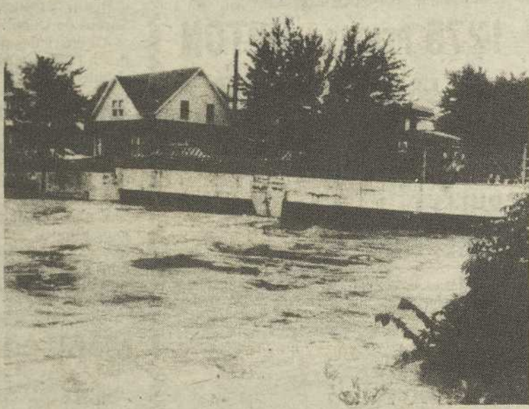
Le 9 août 1972, même un petit canot n'aurait pas pu passer sous le pont de la rue Church, tant la rivière avait été gonflée par les pluies diluviennes.
