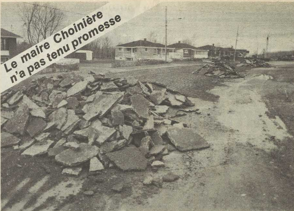
Les rues de la Place St-Louis ont été démolies en '82 pour permettre la construction du réseau d'égout.
