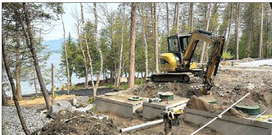
Les installations septiques sont enfouies sous la surface du sol ou dans des cuves de béton.
