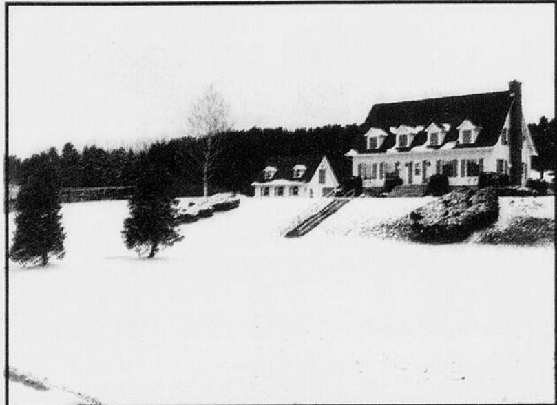
Le bâtiment administratif du complexe de la pépinière d'East Angus, qui a l'allure d'une belle grosse maison canadienne, sera cédée à la Ville d'East Angus pour servir à des fins publiques.
