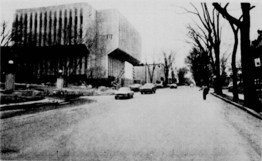
Sur Grande Allée, l'édifice en construction du Gouvernement a des airs de forteresse avec la ligne excoissante de ses pylônes entre lesquels les fenêtres apparaissent comme des meurtrières...
