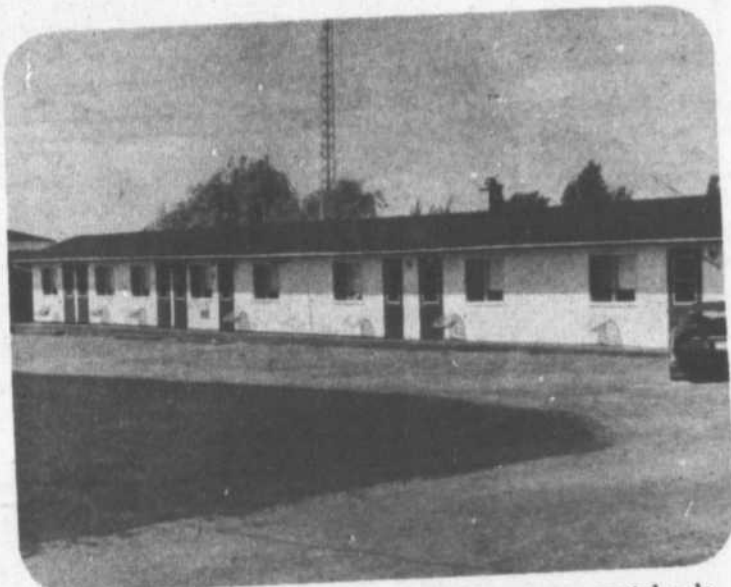
Les motels ont tous été rénovés. En plus, chaque motel a la télévision.
