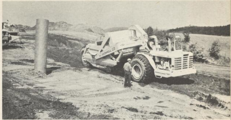
L'entretien adéquat des accès aux zones de remblai aide grandement les décapeuses Alis-Chalmers #360 à vidanger rapidement, sans retard inutile.
