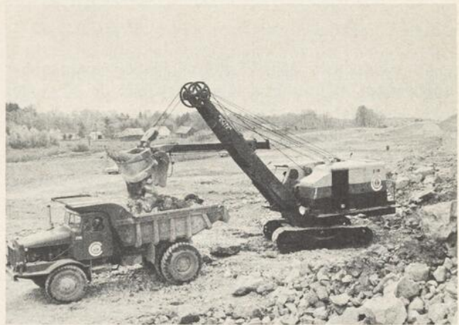
Une pelle Bucyrus-Erie 38B de 1½ verge cube est affectée au chargement des camions alternativement dans les coupes de roc et les chambres d'emprunt.
