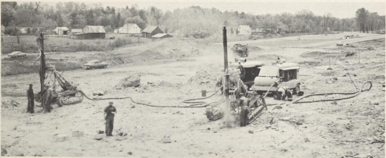
Deux foreuses Ingersoll-Rand Crawl-IR, utilisées dans une coupe de roc. Le forage s'opère selon un plan irrégulier et le dynamitage est effectué à l'aide d'explosifs C-I-L. Les débris servent à remblayer.
