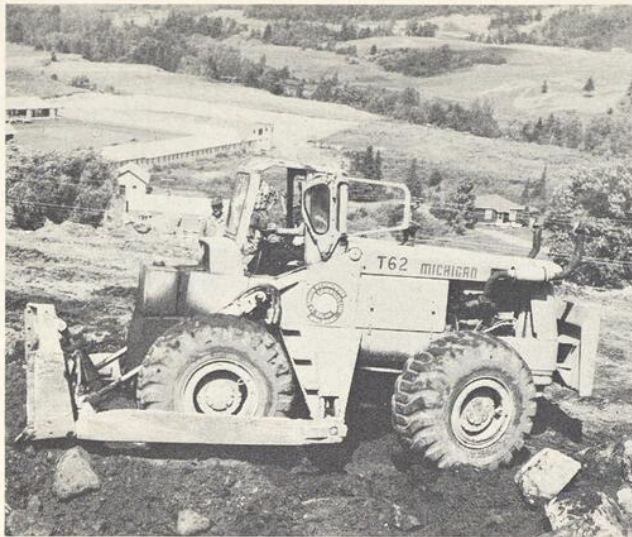
L'équipement utilisé pour les travaux de terrassement est d'une grande diversité. Sur cette vignette, nous distinguons un tracteur sur roues Michigan équipé d'une lame bautoir et de pneus à basse pression.
