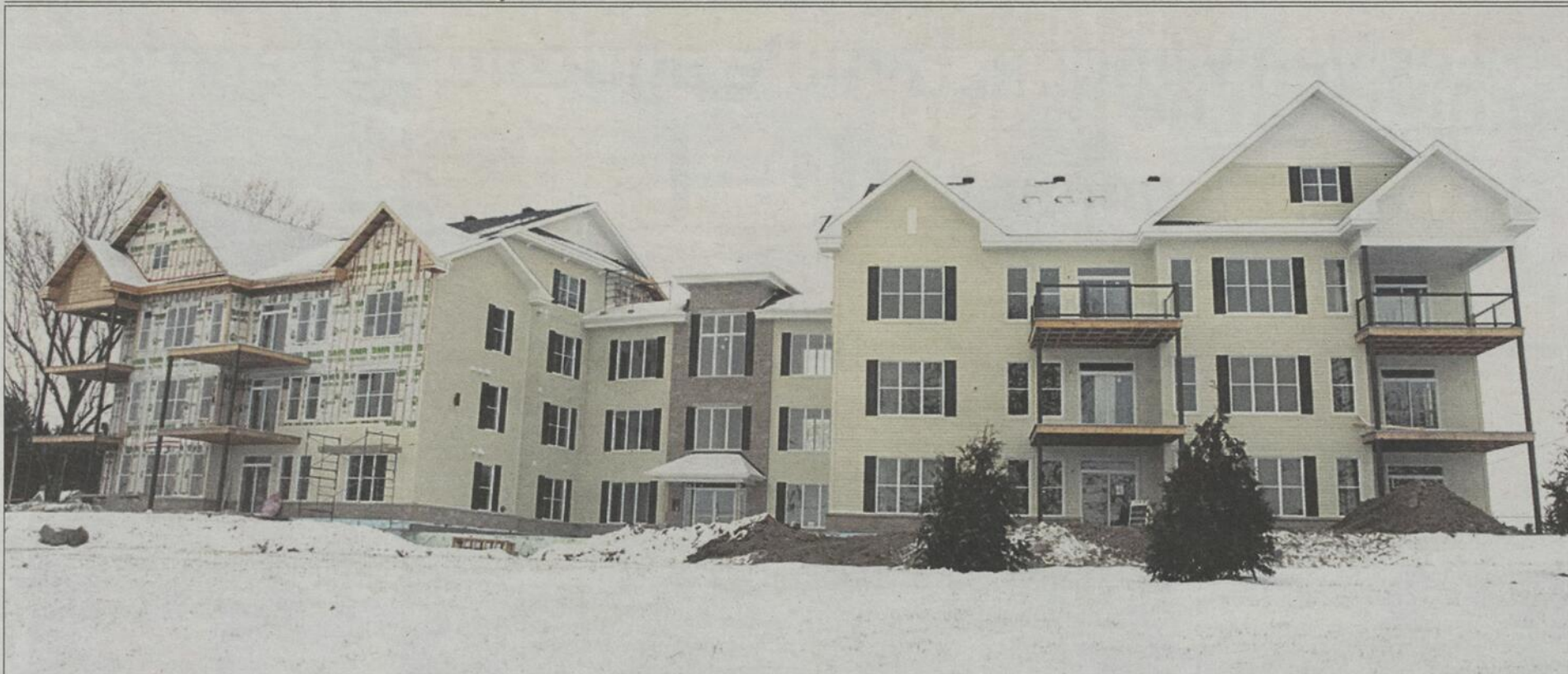
L'intérieur des premières unités ainsi que les stationnements, les ascenseurs et les halls d'entrée seront terminés à temps pour les fêtes.
