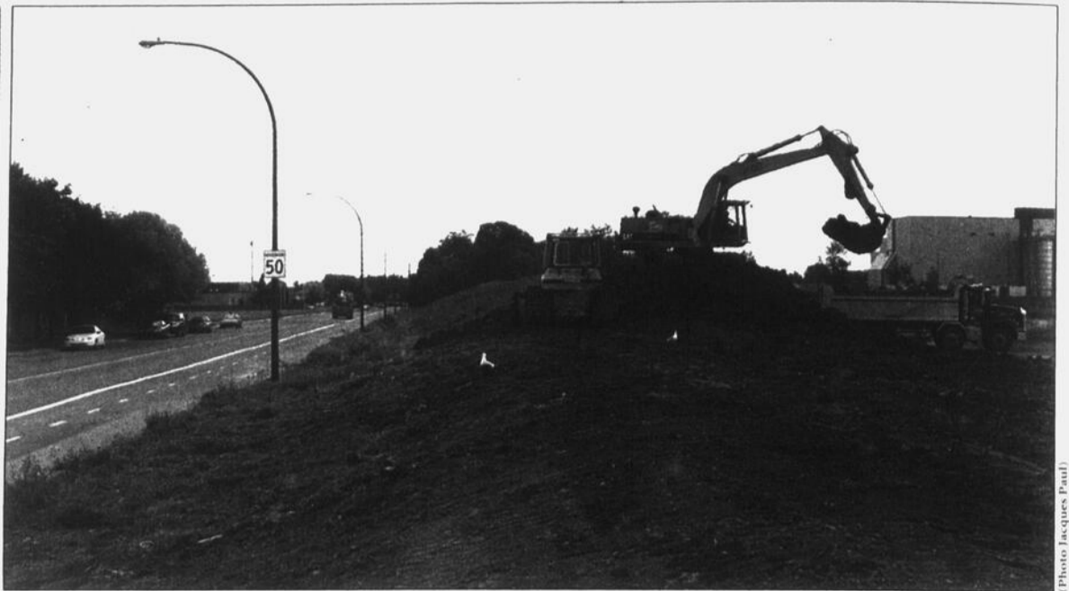
Le talus de plus de 3,5 mètres de hauteur a disparu du paysage au cours des derniers jours.
