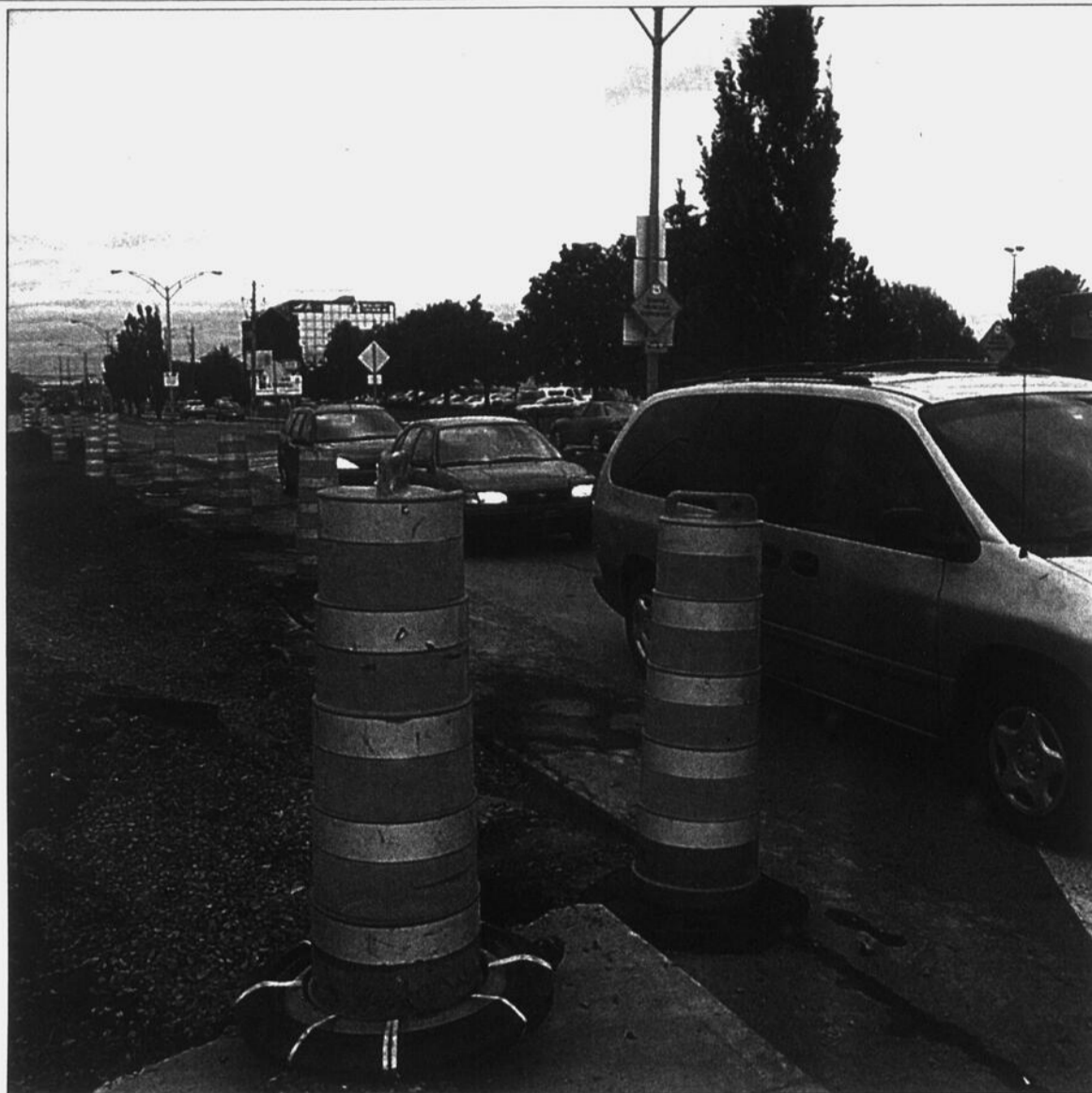
Les travaux sont amorcés sur MacDonald.
