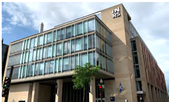
Édifice INRS au centre-ville de Québec
