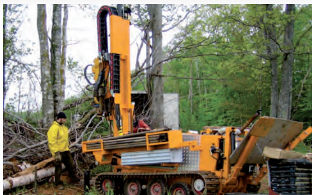
Foreuse Geotech sur le terrain
