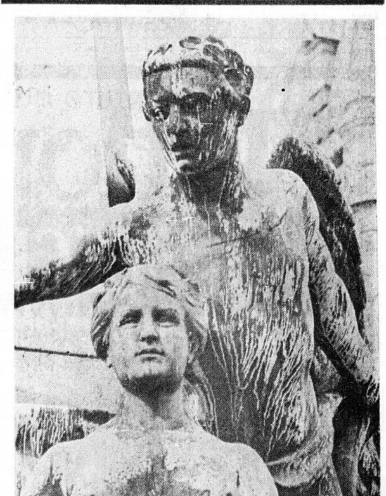
UN NETTOYAGE S'IMPOSE — La vue de certains monuments de la ville de Québec laisse bien des citoyens estomaqués. Un grand nettoyage s'impose. En voici une preuve. Autre photo et détails à la page 3
