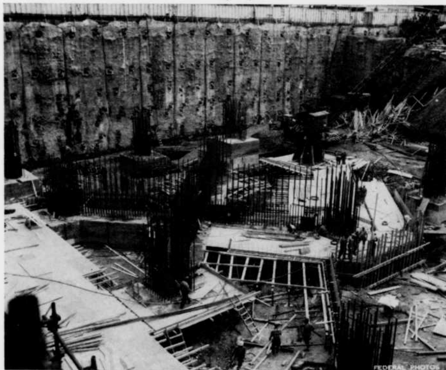
Fig. 4 — Les câbles d'attache du mur-diaphragme étaient ancrés dans le roc solide.
