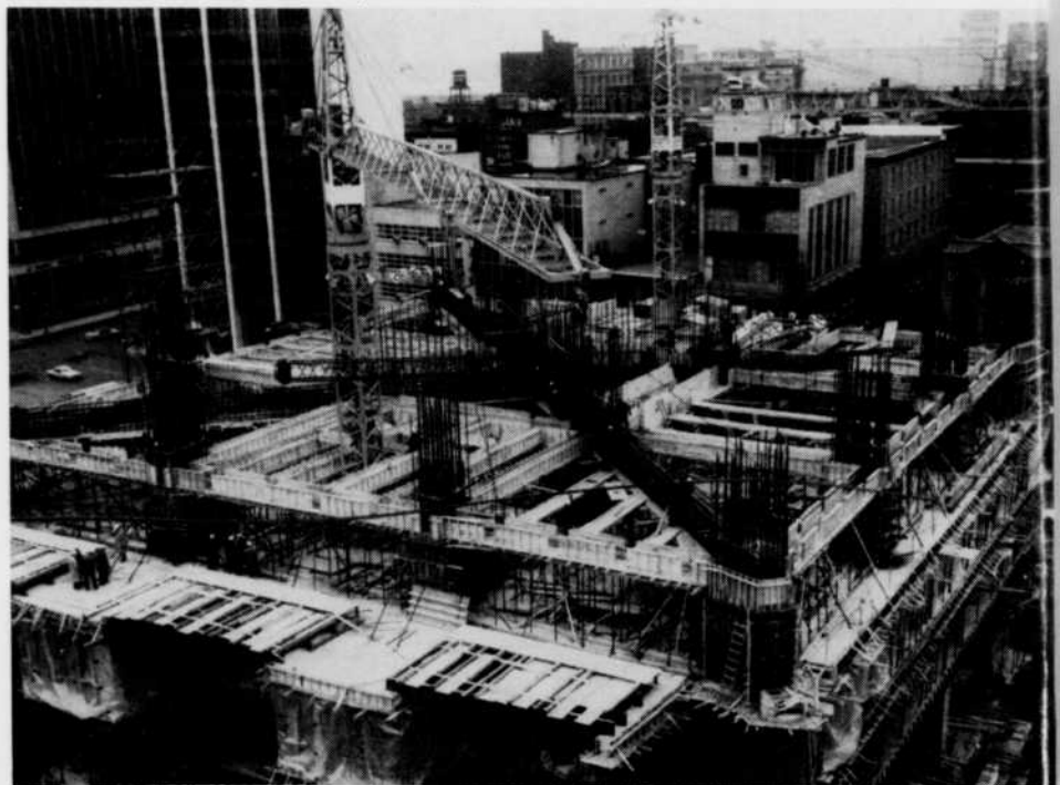
Fig. 3 — Le premier étage de la mécanique, au stade des coffrages.
