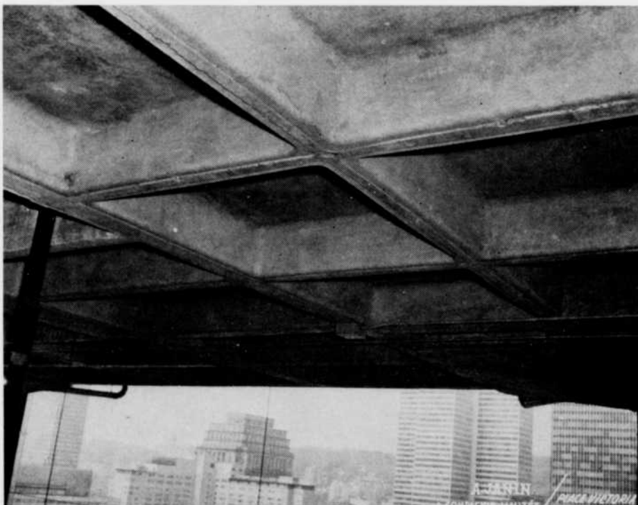
Fig. 6 — Le dessous d'une dalle de béton.
