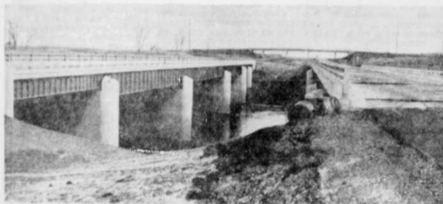
Ponts jumelés qui enjambent la rivière Yamaska
