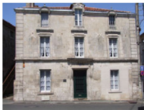
Maison des Bourgouin, 20 rue Rabelais, Fontenay-le-Comte. Une plaque apposée en 1995 à gauche de la porte d'entrée rappelle notre ancêtre.
