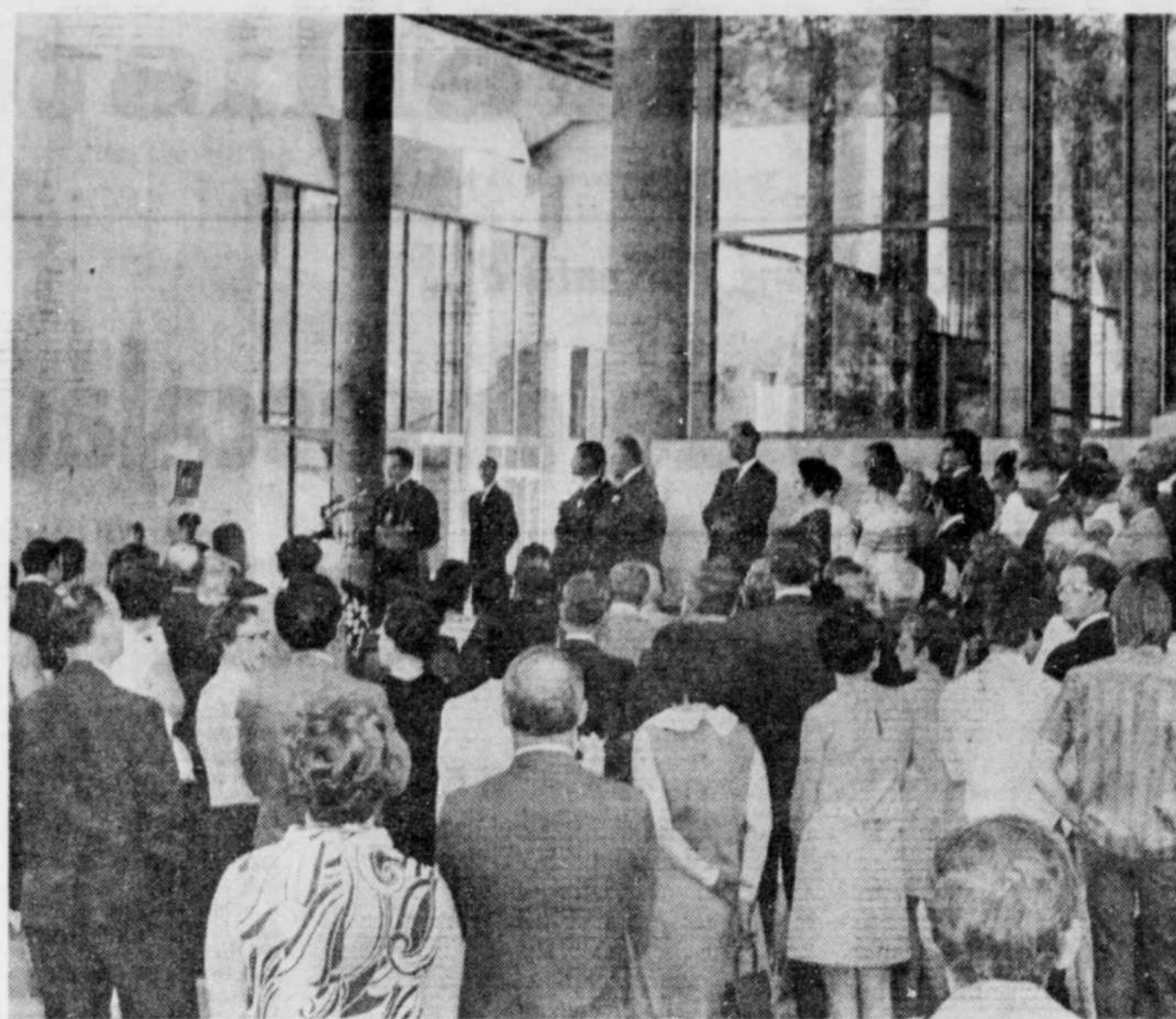
C'EST PAR CENTAINES que les citoyens de Trois-Rivières et de la région se sont déplacés pour assister à l'inauguration de cet orgueil trifluvien qu'est le Centre culturel.
