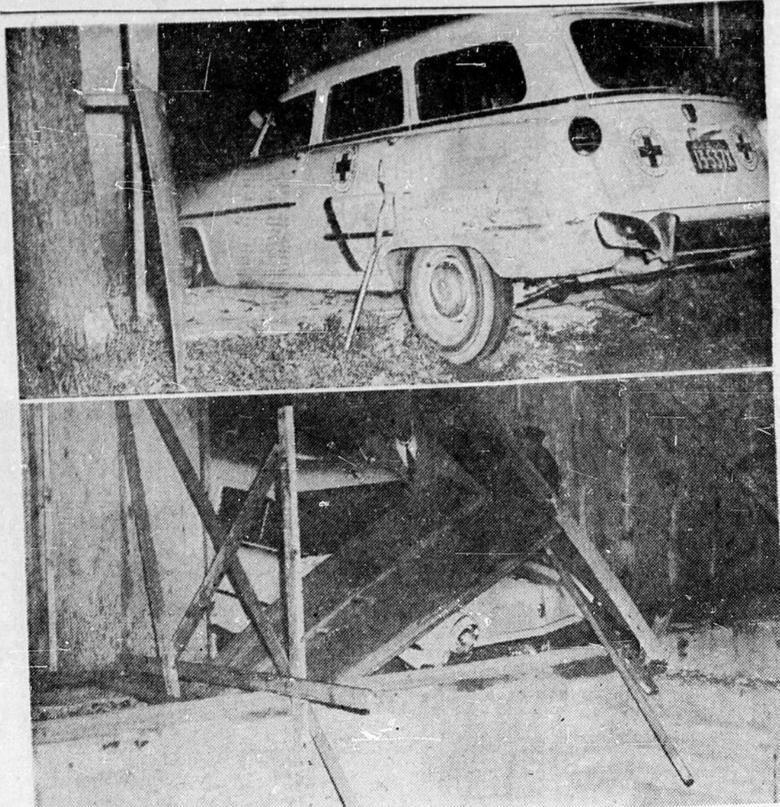
ELLE ARRETE A TEMPS — Cette ambulance de la Croix-Rouge s'est arrêtée juste au bord d'un trou de fondations après avoir enfoncé le mur d'un chantier de construction, rue
