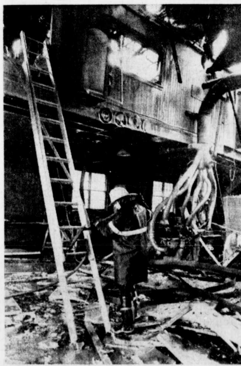
Les dégâts à la bâtisse abritant le moulin à scie de la compagnie Jos. Morneau, à Charlesbourg, dépassent les $125,000.
