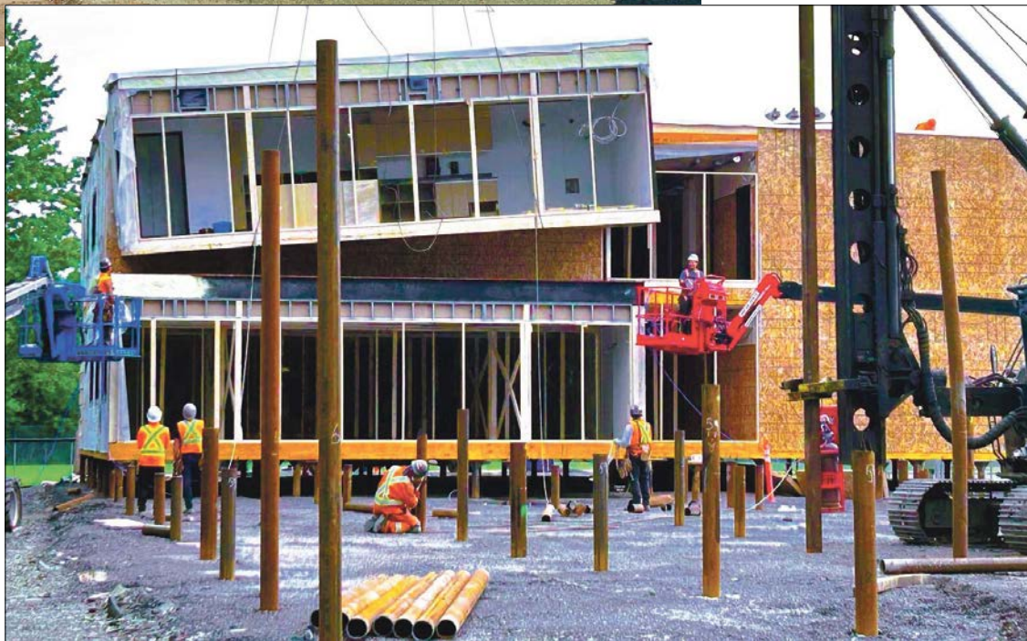
L'école Clair-soleil, à Lévis est faite avec 76 blocs préfabriqués qui peuvent durer jusqu'à 50 ans. Cette nouvelle école primaire, entièrement faite de modules préfabriqués, a été achevée en six mois.
