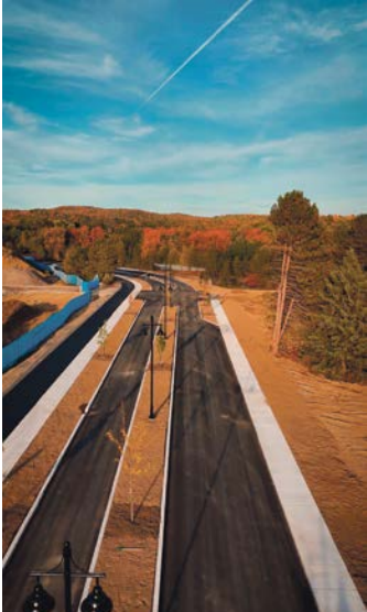
Resurfacement de rues
