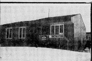
Rimouski, rue des Alouettes , 1 maison neuve en construction, 5 1/2 pièces, peinture et couleur couvre-planchers à discuter.
