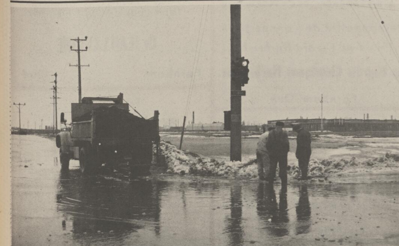
DES INONDATIONS... Avec la pluie diluvienne qui s'est abattue durant toute la journée d'hier, à Saint-Jean et dans la région, les employés de la voirie municipale de Saint-Jean ont dû déblayer les puisards le long du boulevard du Séminaire et des rues transversales, afin d'éviter des inondations dans les sous-sols des demeures longeant cette principale artère de la cité.
